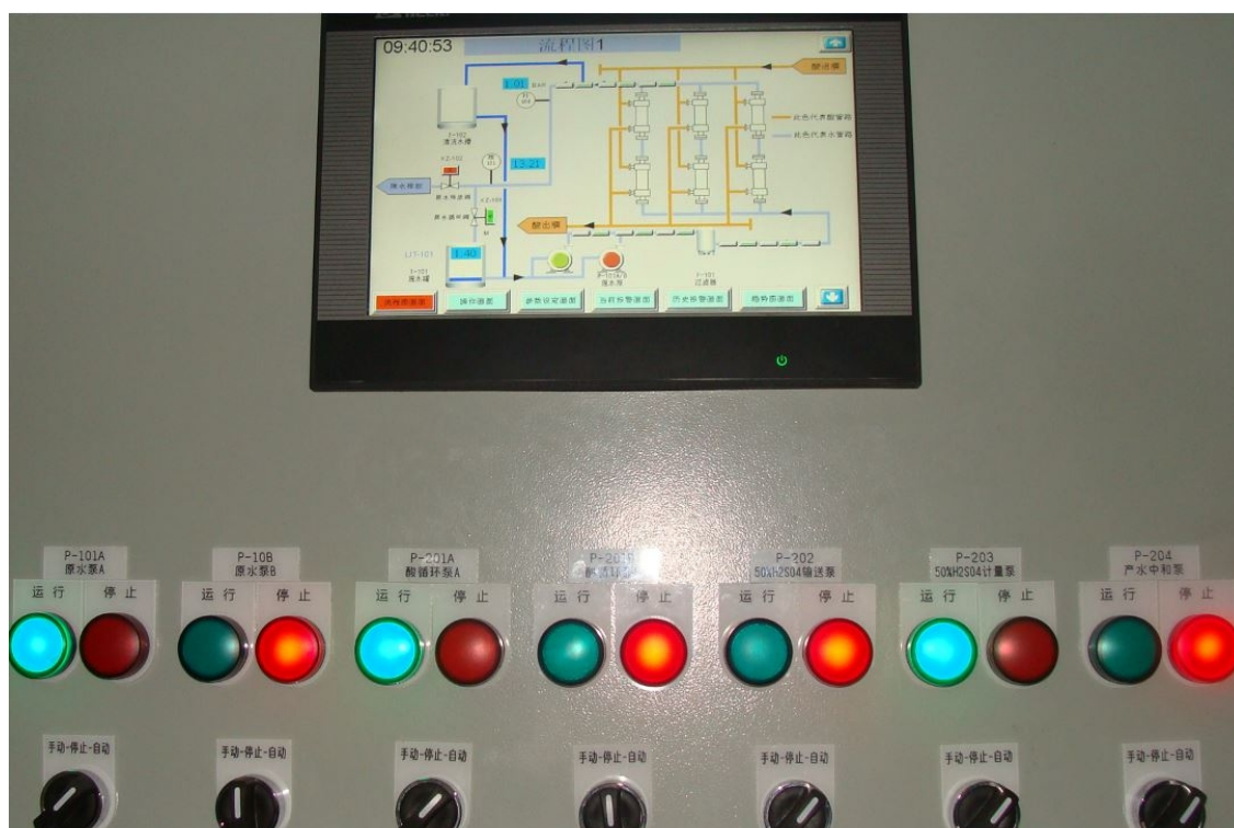
图 8.2-5 氨氮脱除自控系统实例
