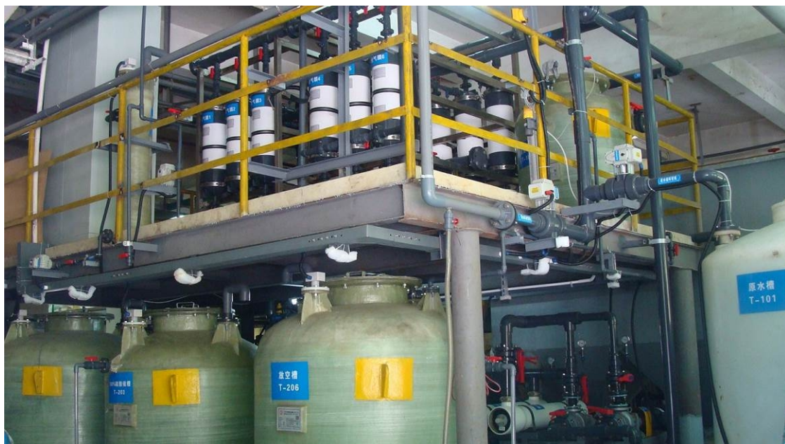
图 8.2-4 氨氮脱除膜主机+吸收系统+膜恢复系统实例
