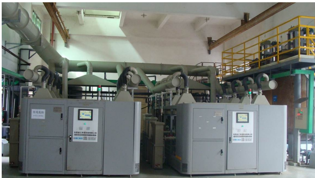
图 8.2-6 紫外光芬顿氧化设备实例
